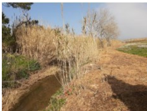
Tratti del Canale prima degli interventi
