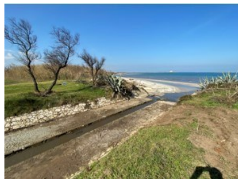
Tratti del Canale a seguito degli interventi
