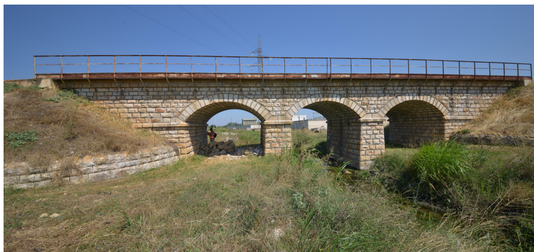
Fig. 33 – Attraversamento BR05500001FV (Francavilla Fontana), adeguatamente dimensionato per un tempo di ritorno di 30 anni
