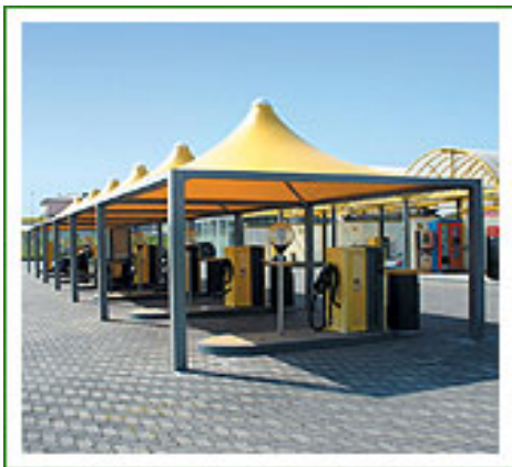
Coperture in pvc, struttura in acciaio
