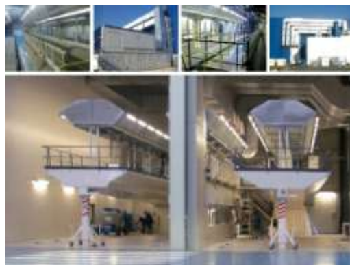
Messa in marcia e collaudo di celle in lavorazione
