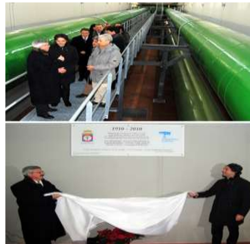
15/12/2010 – Giornata di inaugurazione del nuovo serbatoio
