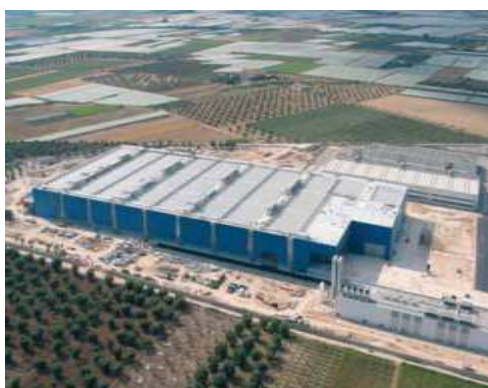
Vista aerea del complesso e suo inserimento nel paesaggio pugliese
