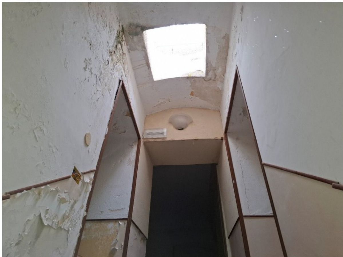
Figura 12. Botola di accesso alla copertura
