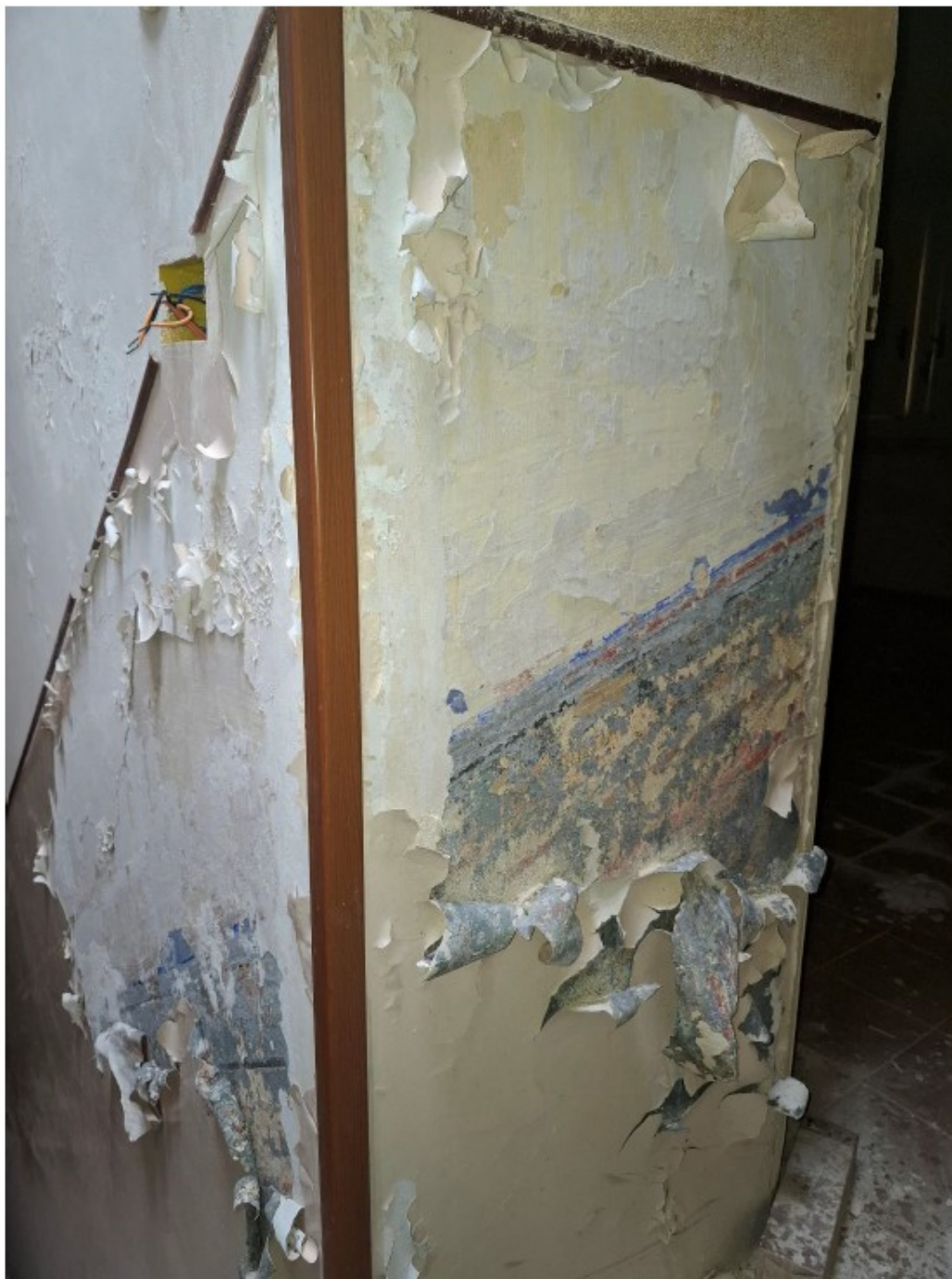
Figura 14. Dettaglio degrado superfici interne
