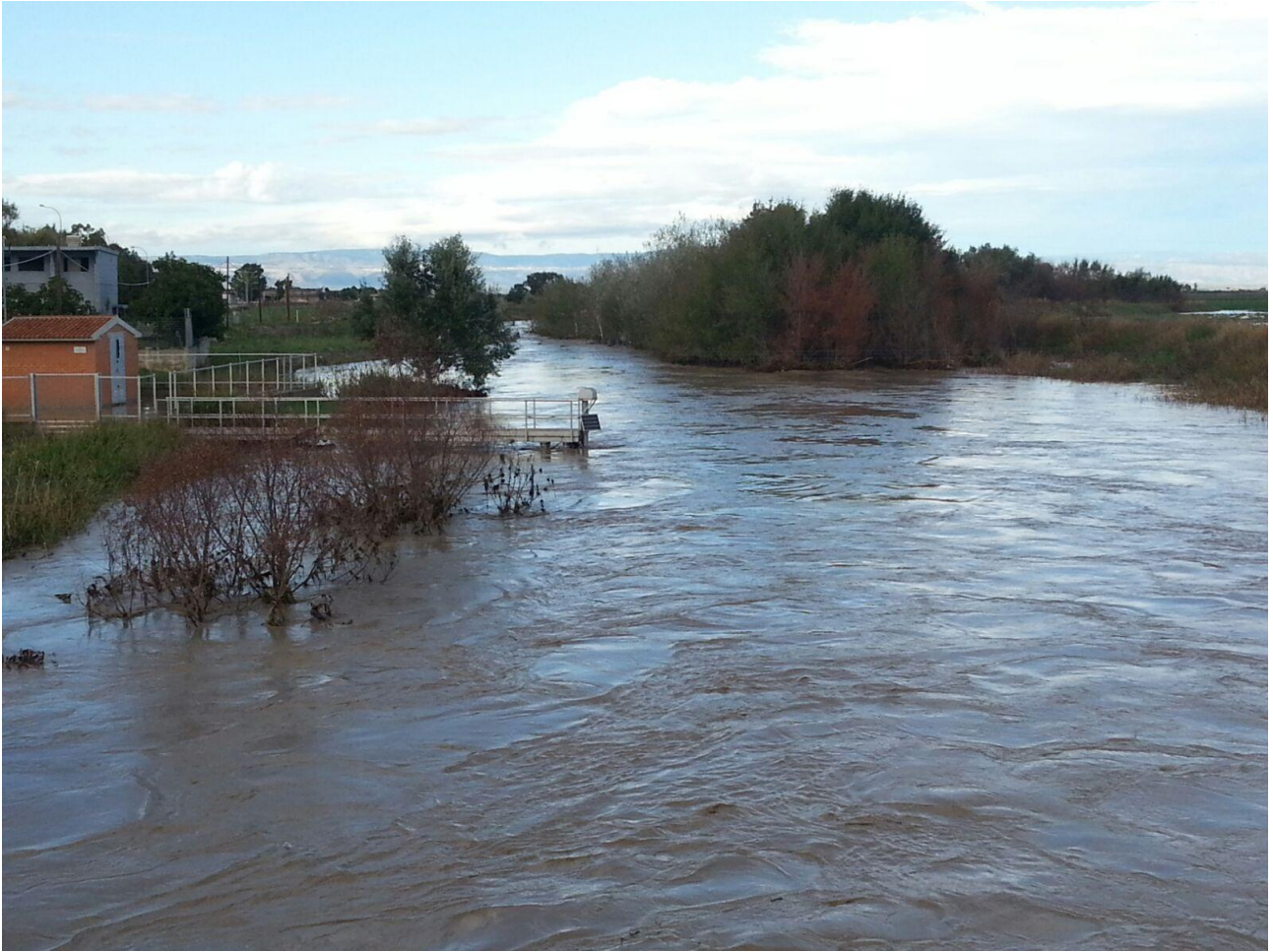
Fig. 20 Torrente Cervaro a pte Incoronata in corrispondenza dell'idrometro
