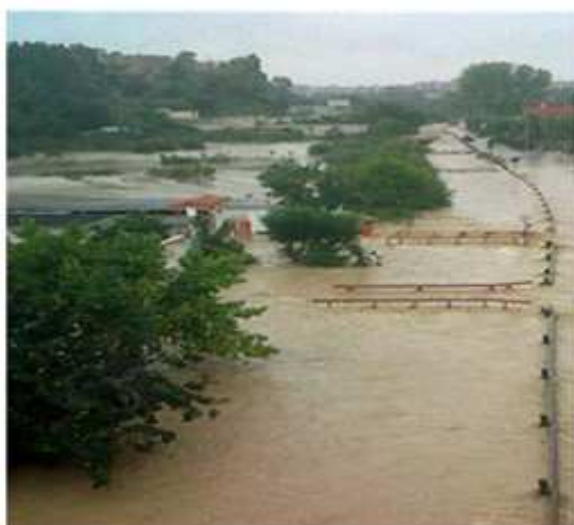
Esondazione canale Patri Brindisi
