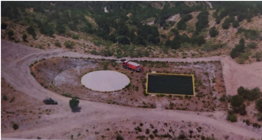
Figura 11.6 Esempio di punto di approvvigionamento idrico utilizzabile dai mezzi ad ala rotante e dai mezzi terrestri.
