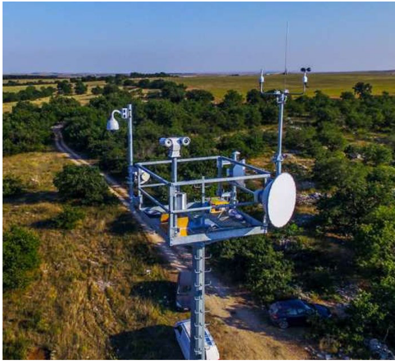
Figura 4.5 Sistema integrato di monitoraggio ambientale e telerilevamento incendi boschivi (ARIF).
