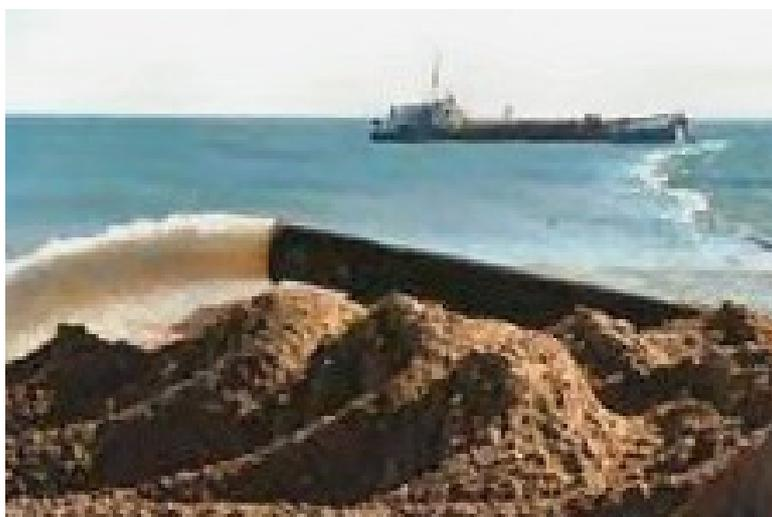
*Fig. 2.1.9.6 - Operazioni di ripascimento effettuato mediante dragaggio.*
