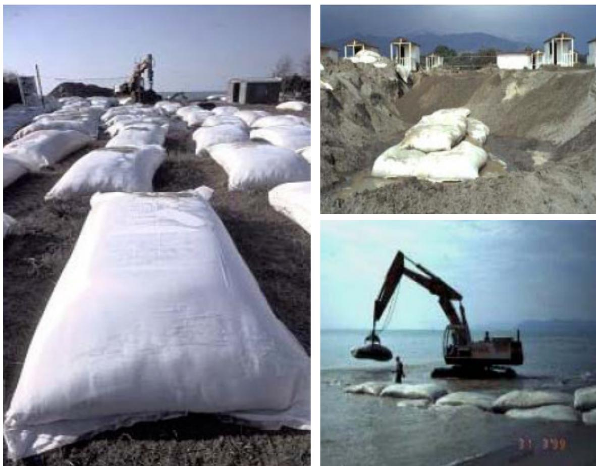
*Fig. 3.2.6.8 - Costruzione dei pennelli sulla spiaggia di Marina dei Ronchi. Fasi del riempimento (foto a sinistra) e del posizionamento dei sacchi rispettivamente in trincea (foto a destra in alto) e in mare (foto a destra in basso).*
