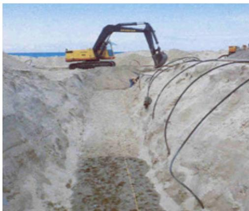
*Fig. 3.2.4.5a - Lavori di scavo delle trincee.*
