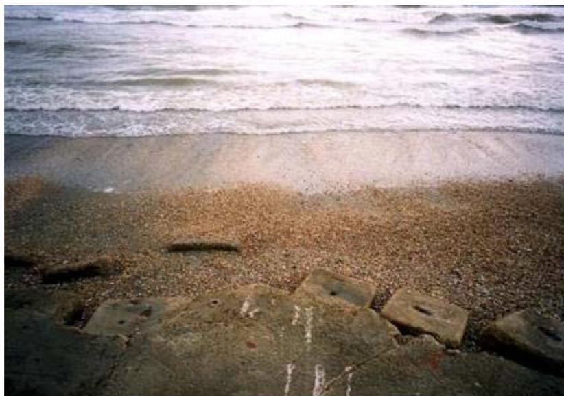
*Fig. 3.2.4.6 - Massi caduti dalla bassa scogliera sul dreno del modulo centrale a Sud del ristorante.*
