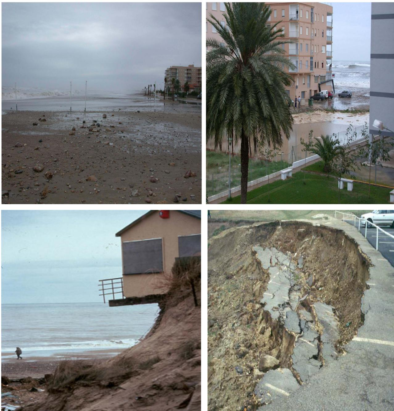
*Fig. 1.2.5 - Abitazioni e infrastrutture compromesse dall'erosione.*
