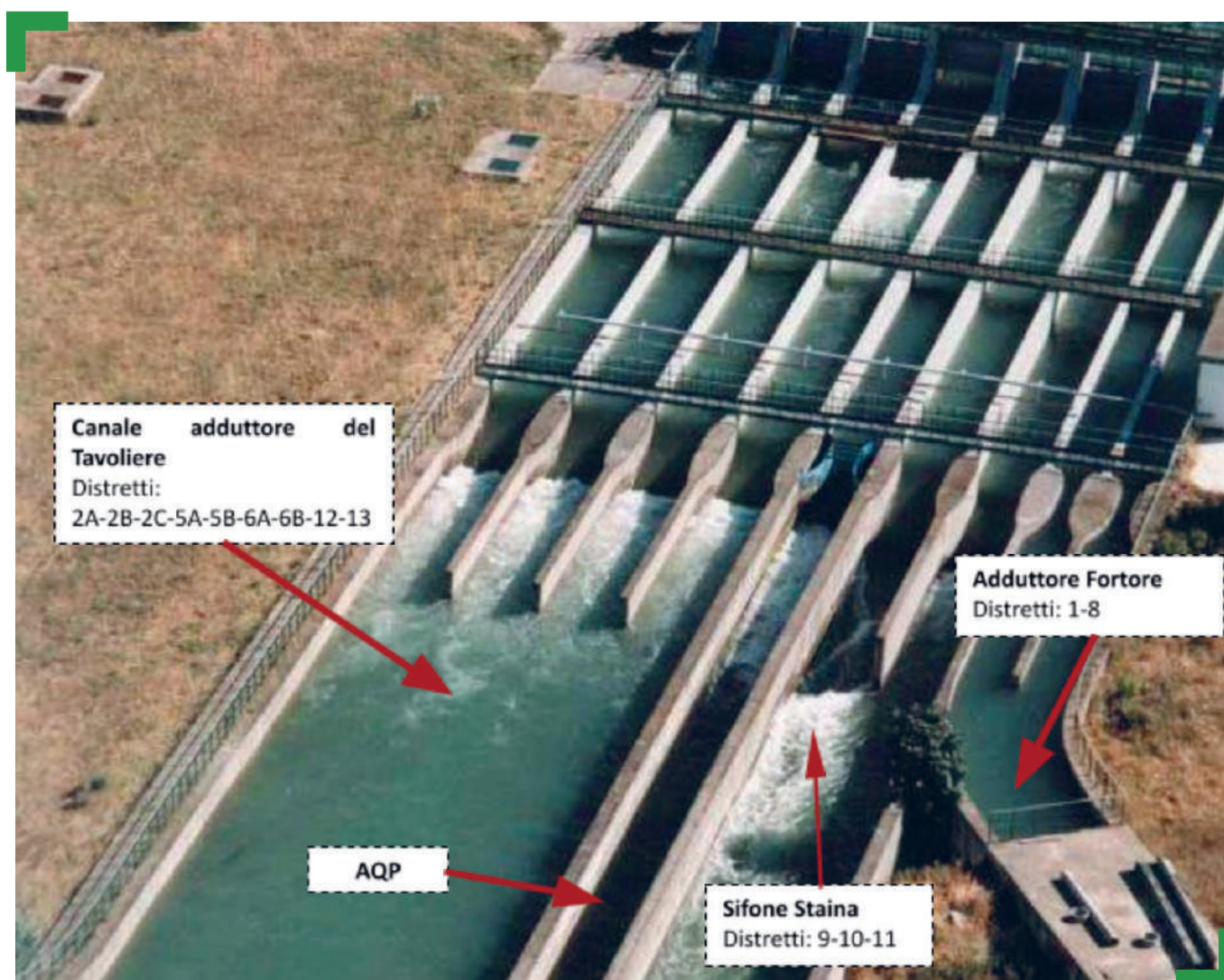
Figura 13. Derivazioni che si dipartono dalla vasca di Finocchito, con indicazione degli adduttori
