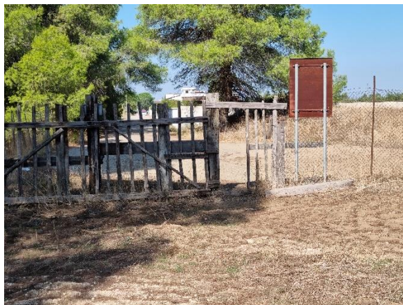
Cancello in legno (perimetrale 13-14)
